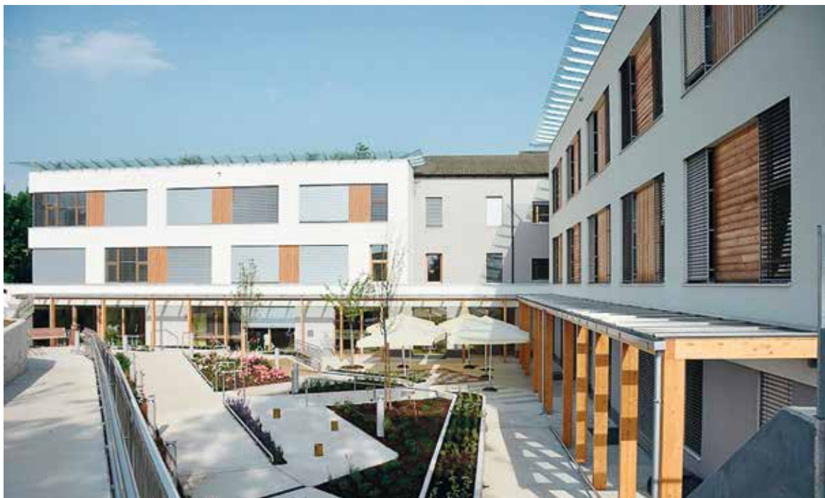
Končana prenova predstavlja največjo investicijo URI – Soča v zadnjih 20 letih in pomeni dolgoročno infrastrukturno ureditev izvajanja rehabilitacije za paciente s področja travmatologije.
